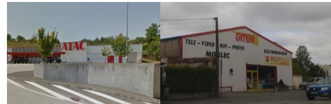
Faible qualité du bâti et de l'accès - Pontallier-sur-Saône / Mirebeau-sur-Bèze
