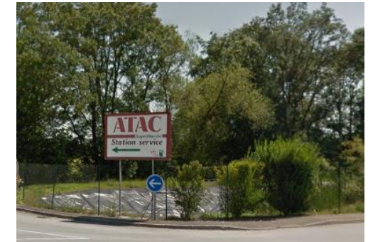
Bassin de rétention des eaux de pluie – Pontallier-sur-Saône
